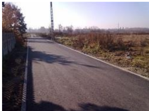
ul. Budzyńska po remoncie
